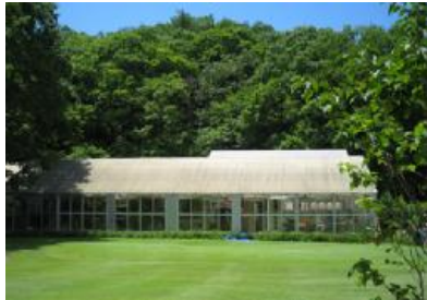
ガーデントロピカ ハウス外観
